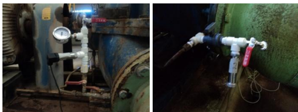
Figura 5. Instalação dos medidores de pressão
